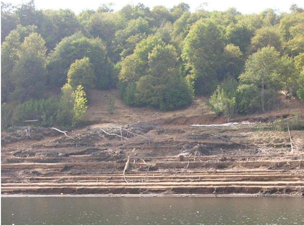
Figura 6: Erosión superficial escalonada típica por efecto del oleaje
