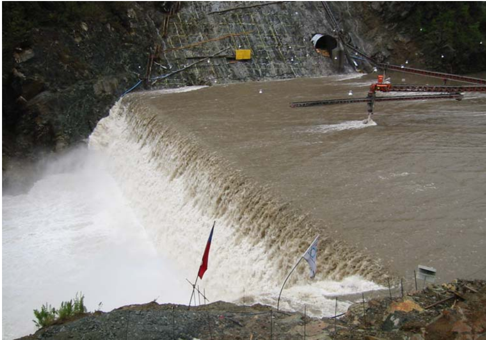
Figura 1 Segundo vertimiento ocurrido en Octubre 2002.
